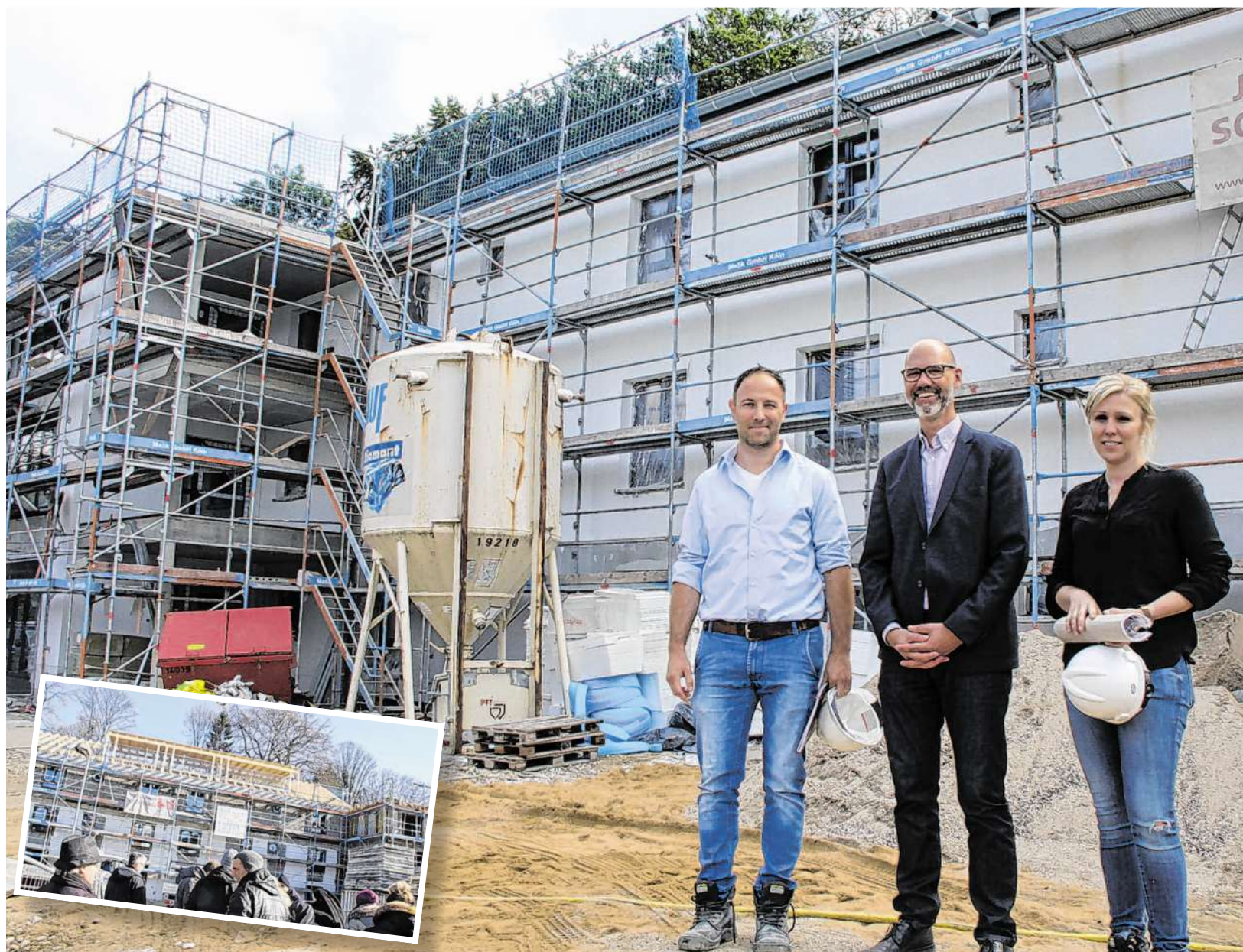
Auf der Baustelle geht es voran: Darüber freuen sich die Architekten Stefan Pennartz (links) und Sarah Walter (rechts) sowie Dirk Renerken (Mitte), Leiter des Heimes des Guten Samaritan. Beim Richtfest im Februar (kleines Bild) sah die Baustelle noch anders aus.
