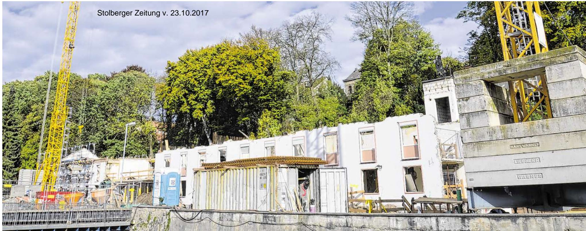
Die Arbeiten am Rohbau am Ufer des Vichtbachs sind im vollen Gange, damit das neue Haus des Guten Samaritan im Optimalfall Ende 2018 bezugsfertig ist.
