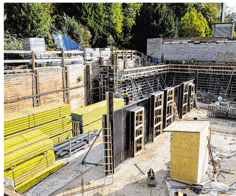
Der Abriss des rechten Gebäudetrakts ist erfolgt und eine neue Bodenplatte bereits fertiggestellt. Hier entsteht unter anderem die neue Tagespflegeeinrichtung des Samaritanerheims.
